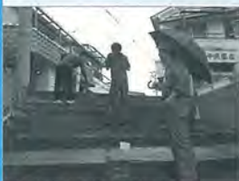
◀階段現地での作業風景
