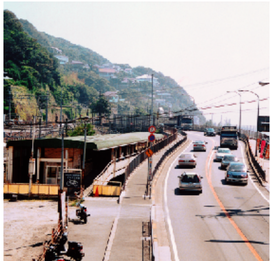
菅公橋付近(国道2号、JR、山陽電鉄が密集している)
