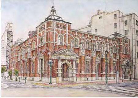
地下鉄みなと元町駅
