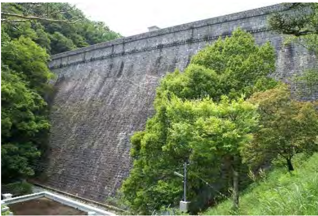
五本松堰堤(布引ダム)
