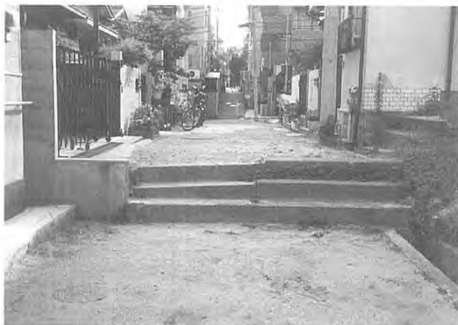
(灘区泉通5丁目・整備前)
